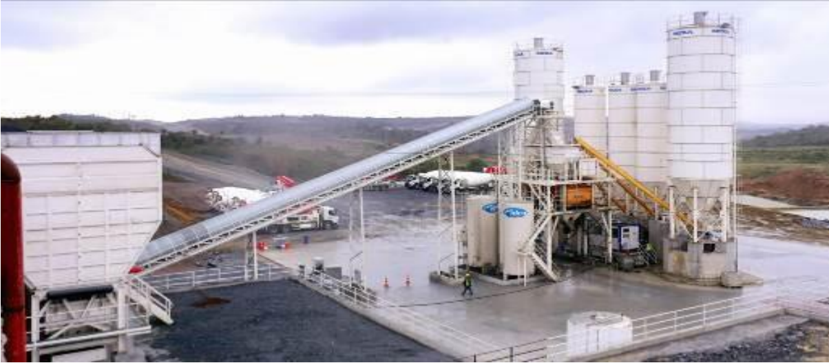
Yeni İstanbul Havalimanı İnşaat Projesi (7 tesis) / Türkiye
