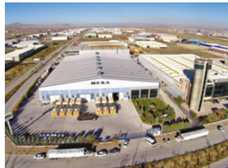
▲ Meka Üretim Tesislerinden / Ankara, Eskişehir
