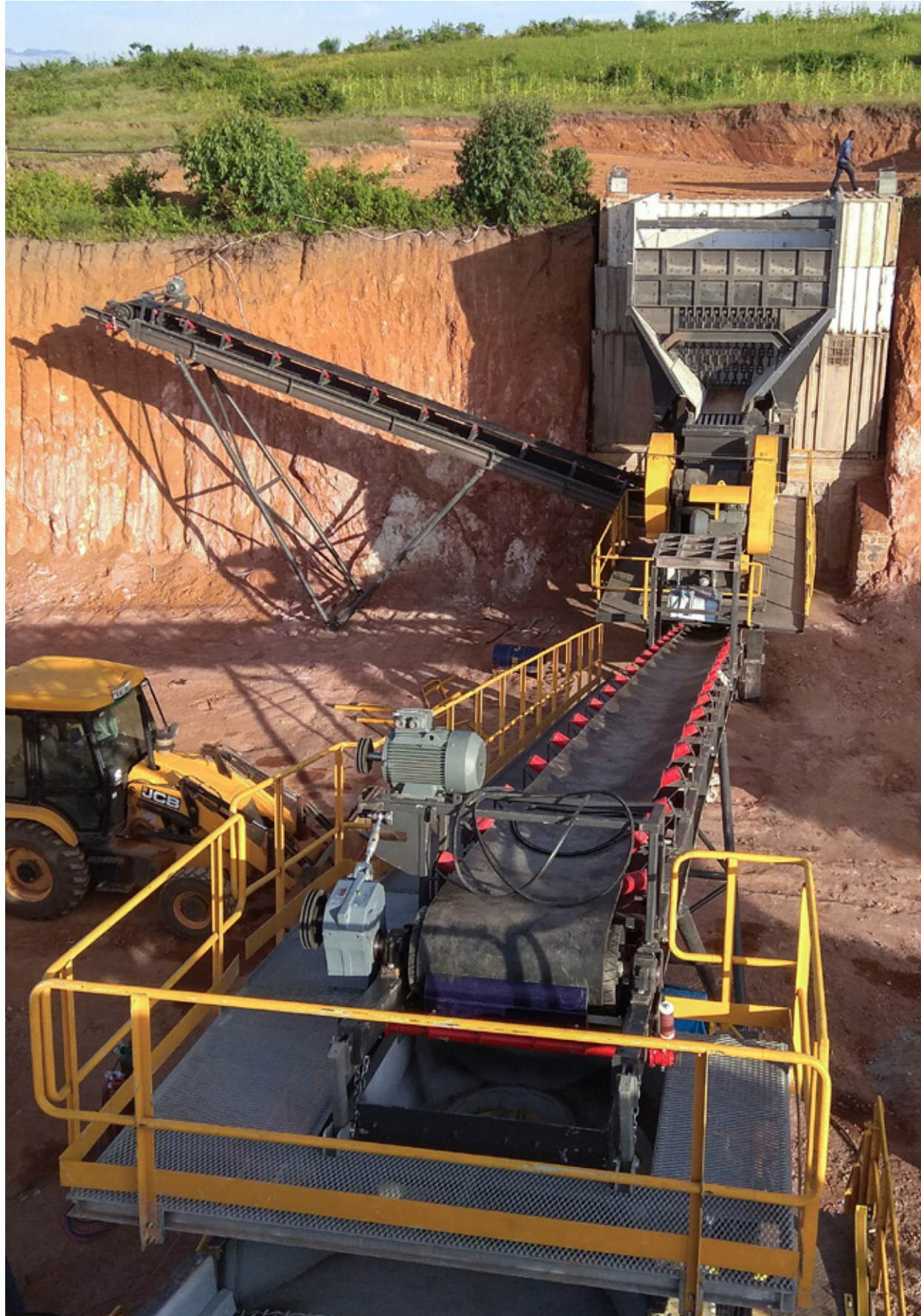
▲ Meka Agrega üretim tesisi montajı / Rwanda
