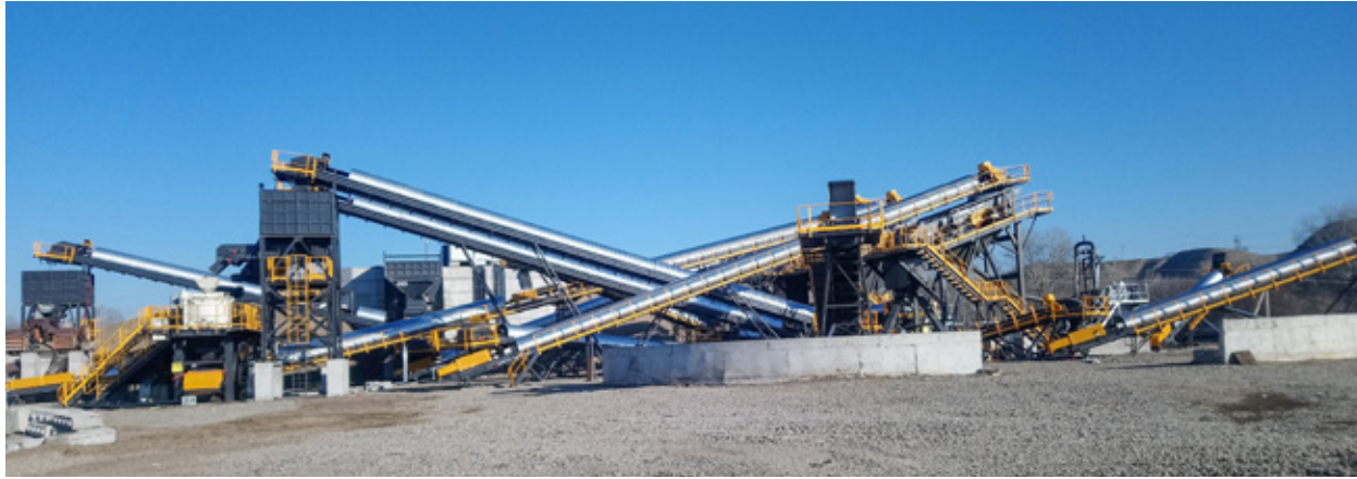
▲ Meka kırma eleme tesisi / Gürcistan
