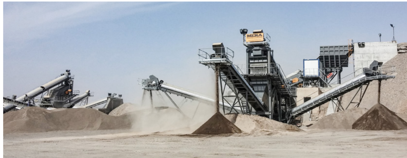
▲ Sarl MEKA Algeria tarafından satışı yapılan bir agrega üretim tesislerinden Cezayir
