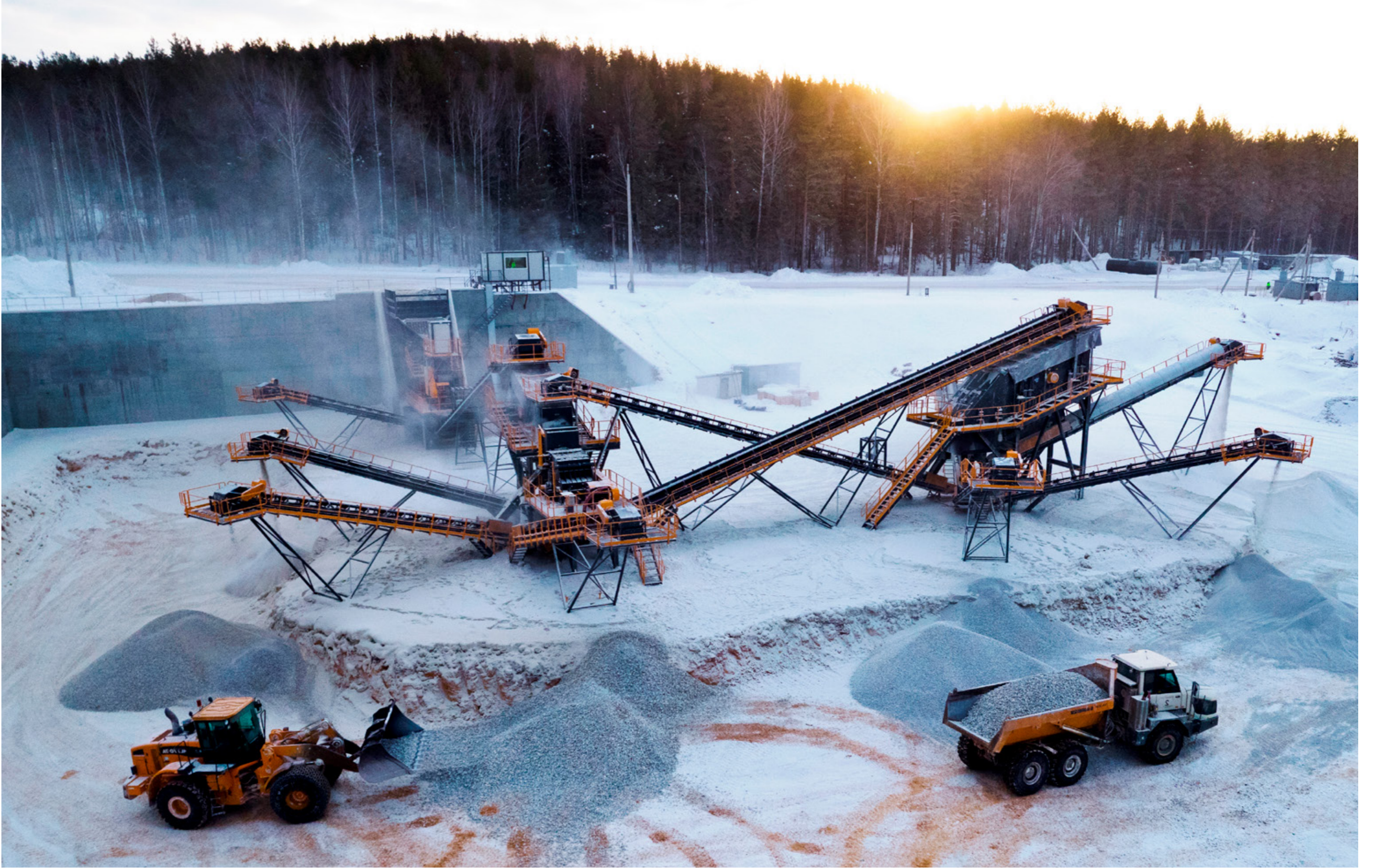
▲ MEKA Agregat Üretim Tesisi Rusya
