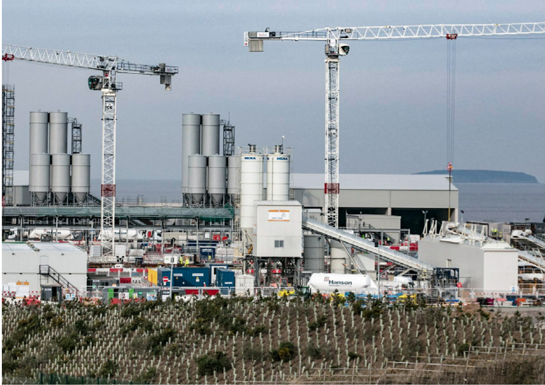
▲ MEKA Beton Santrali Hinkley Point C Nükleer Enerji Santrali İnşaatı Projesi İngiltere
